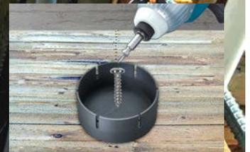
**固定底座：**使用螺絲將定位底座固定在板模上。
