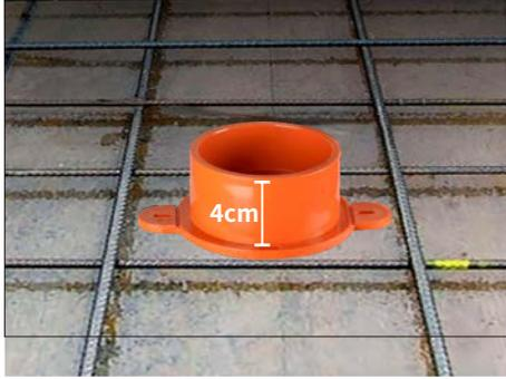
1 將排汙架高底座定位在模板上，並將下層鋼筋綁在4公分的位置。
