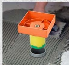
1. 膨脹塞頭，保護水管，防止水泥掉入管內。
