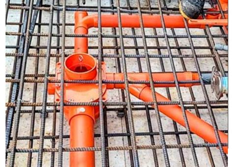
3 將上層鋼筋固定在止水板上方（約22公分）準備灌漿。
